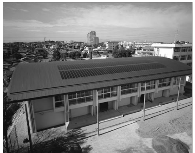
図2 鋼板一体型フィルム型太陽電池
