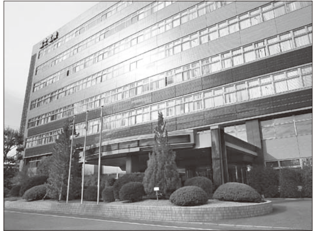
図4 南壁面に設置した太陽電池
