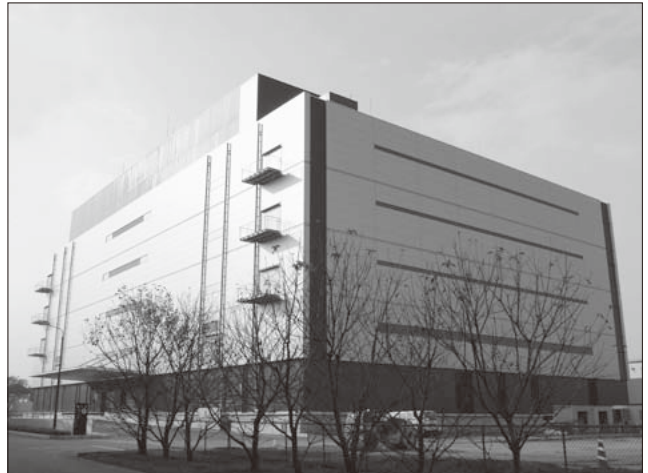
図5 鋼板一体型太陽電池（壁面設置）
