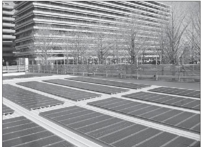
既設の屋根をターゲットにした鋼板折り曲げ型のモジュールの販売も行っている。
