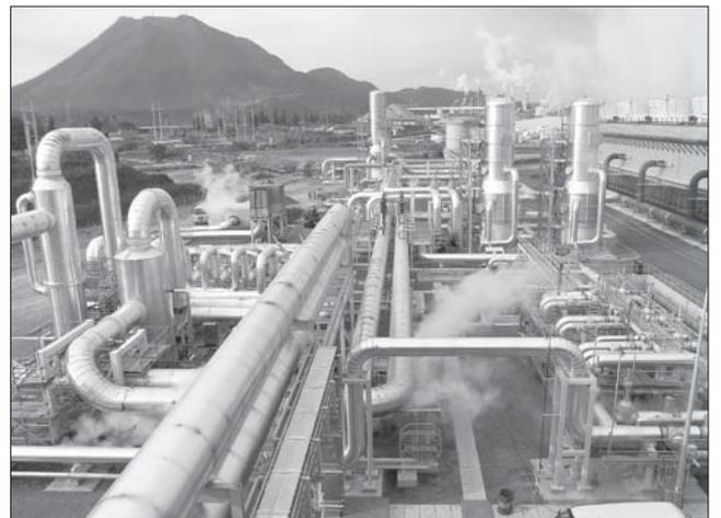
ピン最終段翼を持つ大型の地熱タービンを採用し、定格出力 95.7MW、最大出力 113MW を実現した。発電所は 2006 年 11 月の契約から 22 か月という短期間で 2008 年 8 月に完成させ、顧客に引き渡した。
