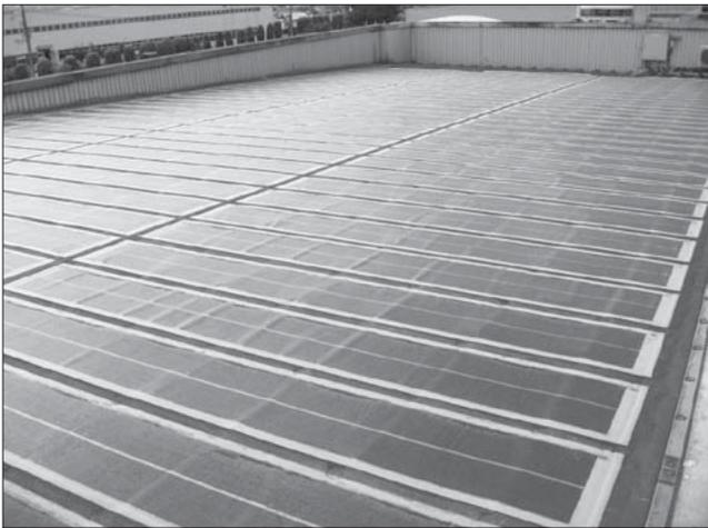
池モジュールを直接鋼板にラミネートした軽量な建材一体型太陽電池モジュールを供給している。通常の鋼板屋根と同じ方法で施工できるため、低コストで意匠性に優れた太陽電池付き鋼板屋根が実現できる。また、フレキシブルであるため、図2に示すように鋼板を湾曲させて曲面に設置でき、ドーム上の屋根やデザイン性が要求されるような場所において高い意匠性を発揮することができる。また建築防水の分野では、防水シートを用いた工法が工期短縮・低コストという点で伸びており、さらにシート状の太陽電池と一体化することで高い付加価値を得ることができる(図3)。
