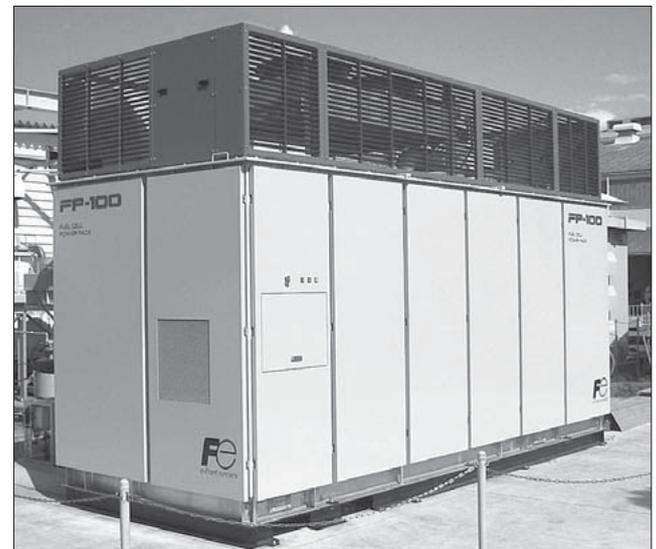
なお、装置の屋根に載せる排熱処理設備は、輸送制限から現地にて組立を行うが、配線接続のコネクタ化と、配管施工を2本に削減し現地工事の簡素化を図った。また、周辺設備を装置へ搭載するためには、各機器の小型、軽量化も図っている。その主な内容を次に記す。
