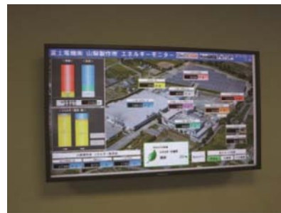
使用しているエネルギーを表示するエネルギーモニター
