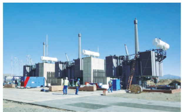
現地工事が進む南アフリカ共和国国営電力会社向けの変電設備 (Eskom社Kappa変電所)
