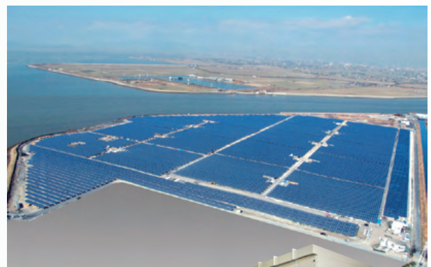
太陽光発電システムの受注・売上拡大に取り組む (九州ソーラーファーム7 みやま合同発電所)
