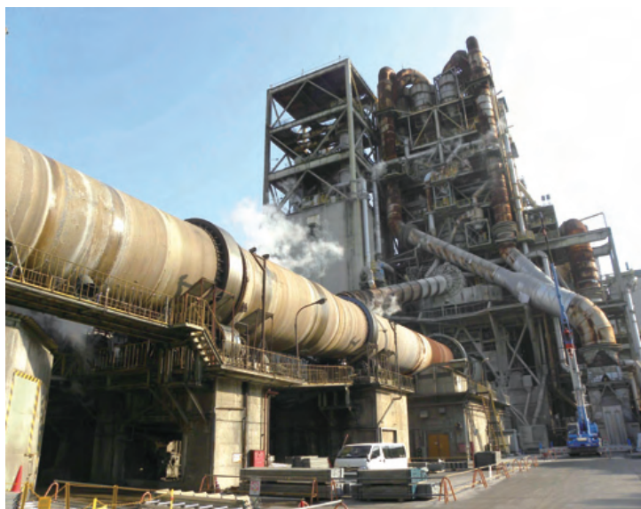
太平洋セメント(株)埼玉工場 手前の円筒がセメント焼成用キルン
