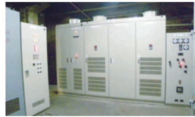
キルンの回転を制御する駆動制御システム (インバータ)
