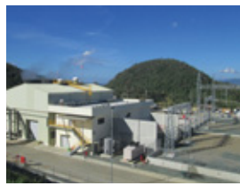
蒸気タービン、復水器などを納入したフィリピン・マイバララ地熱発電所
