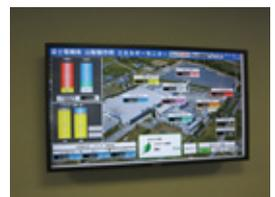
使用しているエネルギーを表示するエネルギーモニタ
