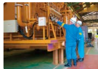
安全パトロールの様子
