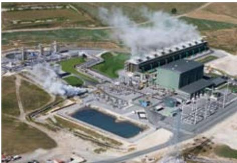
ニュージーランドのナ・アワ・ブルア地熱発電所に納入した世界最大\*出力(140MW)の地熱発電プラント
