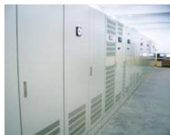
風力発電用の電力安定化装置
