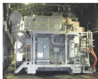
黒鉛化炉用の直流電源設備
