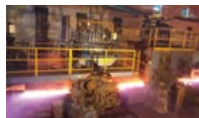
鉄鋼圧延設備
