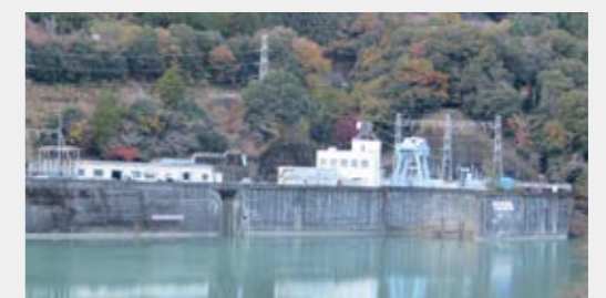
電源開発株式会社様 秋葉第一発電所 (47.2MW 静岡県)
