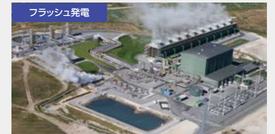
フラッシュ発電 ナ・アワ・プリア地熱発電所 (140MW ニュージーランド)
