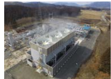
滝上バイナリー発電所
