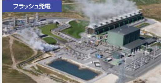
ナ・アワ・プルーア地熱発電所 (140MW ニューゼーランド)
