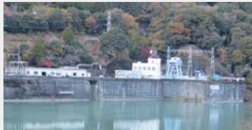
電源開発株式会社様 秋葉第一発電所(47.2MW 静岡県)
