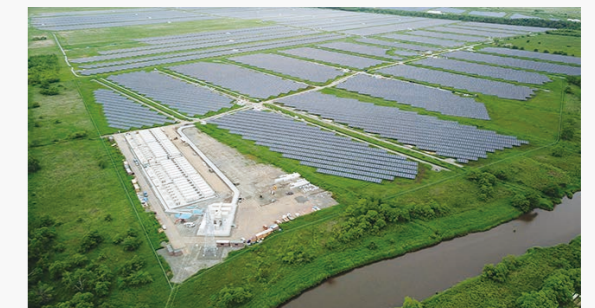
すずらん釧路町太陽光発電所
