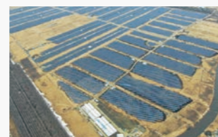
すずらん釧路町太陽光発電所
