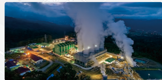
ムアララボ地熱発電所 (Courtesy of PT. SEMI)
