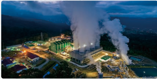
ムアララボ地熱発電所 (Courtesy of PT. SEML)
