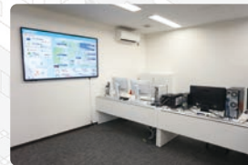
そうまIHIグリーンエネルギーセンター管理棟内(エネルギーマネジメントシステム)
