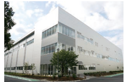
東京工場プラントシステム棟
