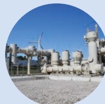
変電システム
