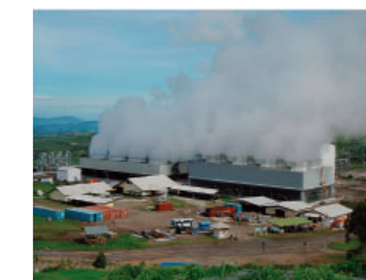
インドネシア ワヤンウィンディ地熱発電所
