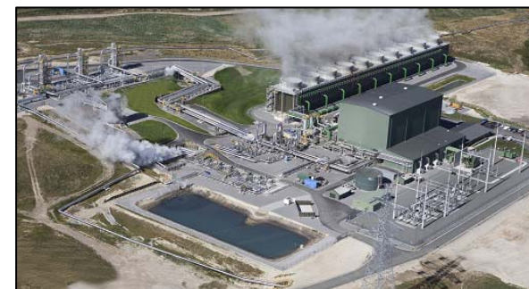
NZ NAP地熱発電所 (2010年4月運転開始) 単機世界最大出力(140MW)
