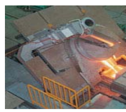
誘導加熱設備
