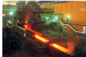
電動力応用プラント
