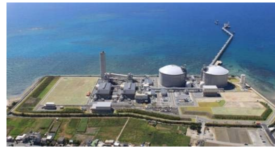
沖縄電力(株) 吉の浦コンバインドサイクル発電所
