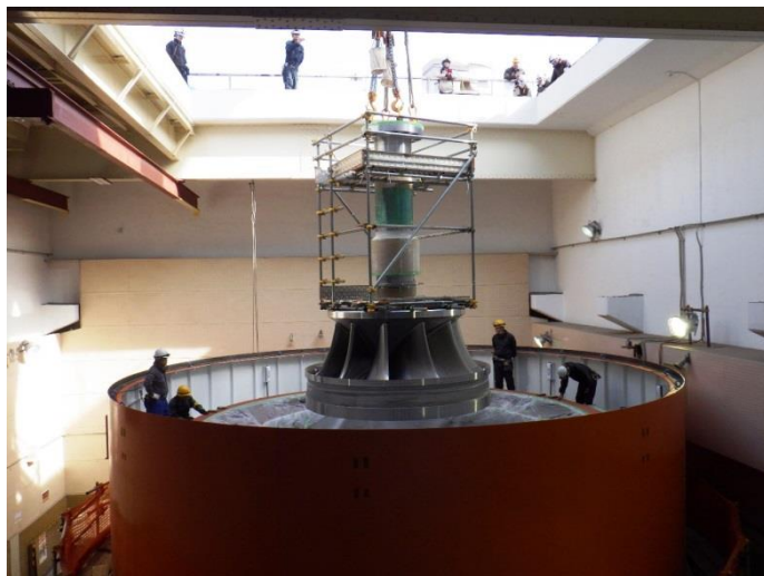
【水車・発電機更新事例】
