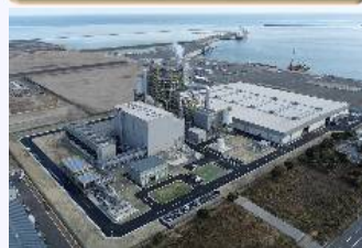
バイオマス発電設備
