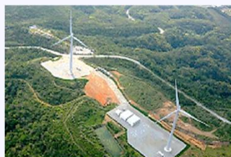
風力発電システム
