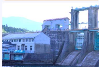
水力発電設備
