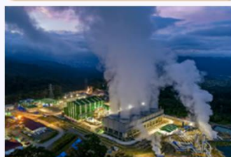
地熱発電設備
