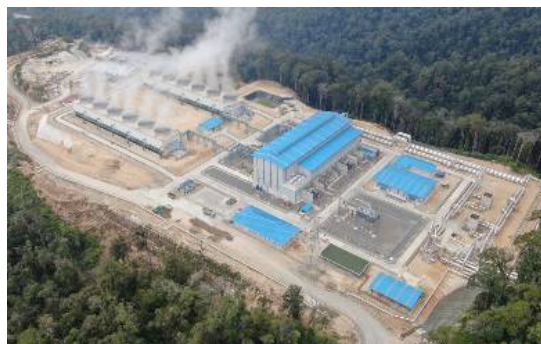
PT SERD様 (画像提供元) Rantau Dedap Geothermal Power Plant
