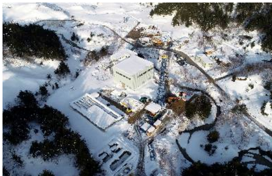
電源開発株式会社様 (画像提供元) 鬼首地熱発電所(建設工事中)
