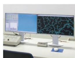
エネルギー管理システム
