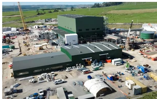
Contact Energy Ltd 様 (画像提供元) Tauhara Geothermal Power Plant (建設工事中)
