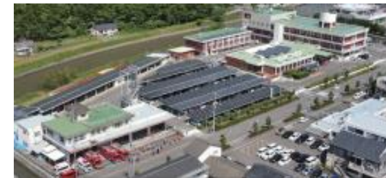
合同会社トラストバンク阿久根様 (画像提供元) 阿久根市庁舎自家消費型太陽光発電所
