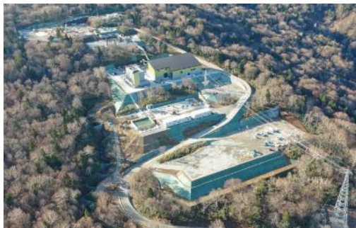
安比地熱株式会社様 (画像提供元) 安比地熱発電所 (建設工事中)
