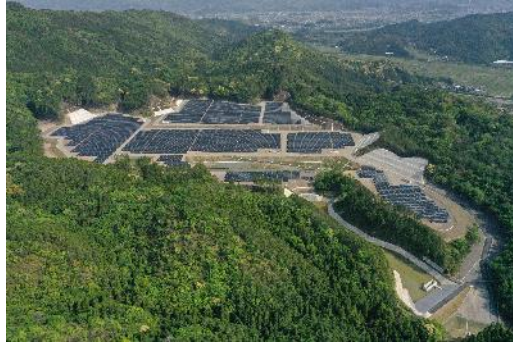
延岡太陽光発電合同会社様 (画像提供元) 延岡くじら池太陽光発電所 (建設工事中)
