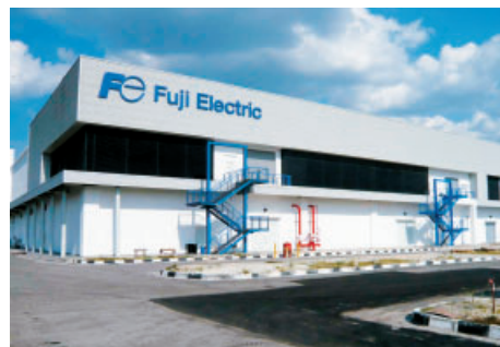
富士電機半導体マレーシア社・新工場棟
