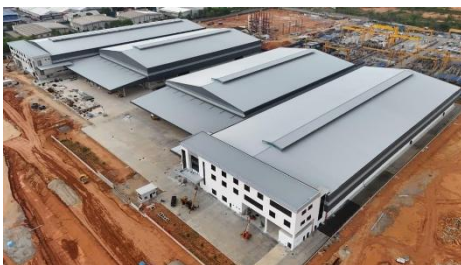
立ち上げ中の新生産棟 （マレーシア工場）
