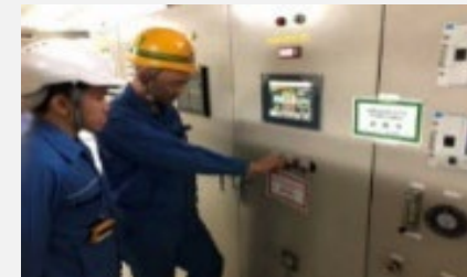
設備工事・サービス
