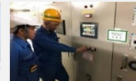
設備工事・サービス
