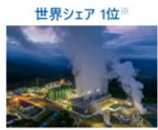
地熱発電設備
