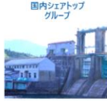
水力発電設備
