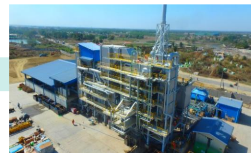
電気設備工事
