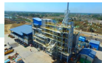
電気設備工事
