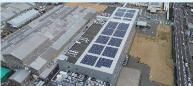
鈴鹿工場の太陽光発電設備
