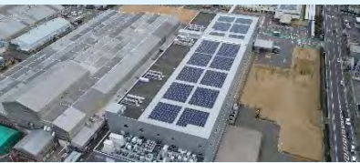
鈴鹿工場の太陽光発電設備
