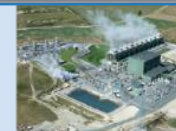
地熱発電設備
