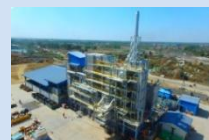
電気・空調設備工事
