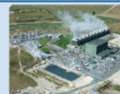
地熱発電設備
