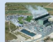
地熱発電設備
