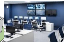
監視システム
