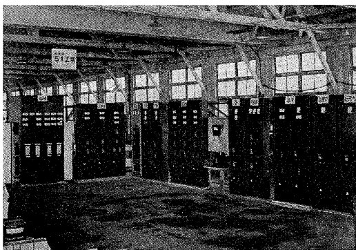
第 XVII・1 図 九州電力遠隔測定装置 Fig. XVII・1 Telemetering sets for Kyushu Denryoku K. K.
