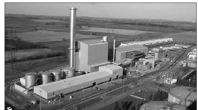
図 3 実際のプラントの外観
