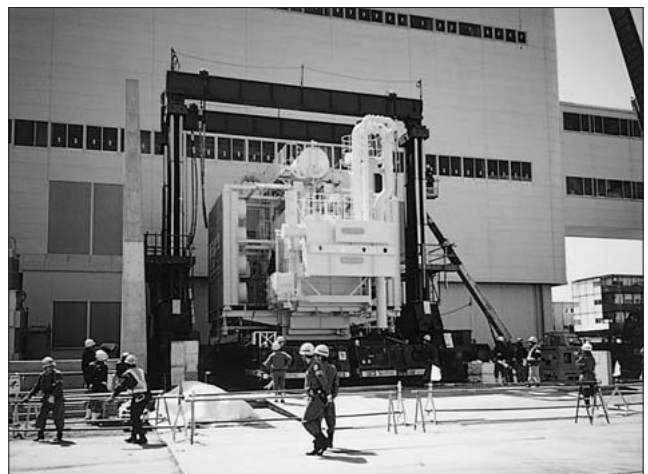
図3 リフトシステムによる据付け作業
