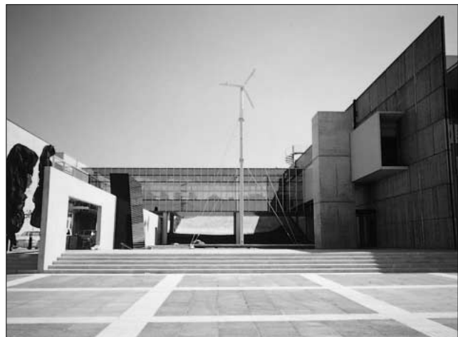
図 12 風力発電設備（風車）
