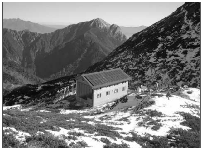
図11 ハイブリッド山小屋（仙丈ヶ岳避難小屋）の全景
