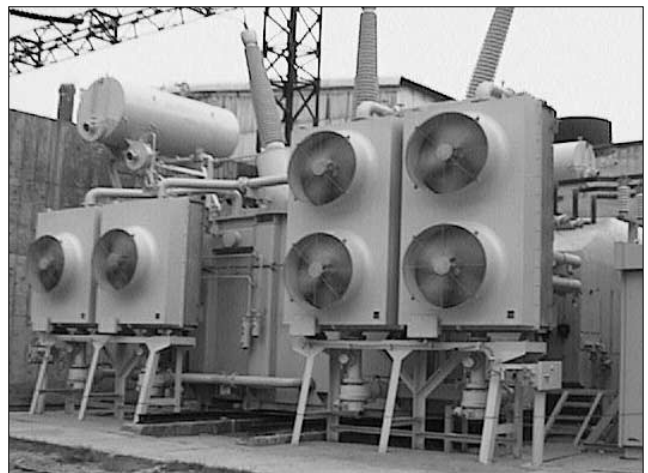
図3 中国・貴州アルミ向けアルミ精錬用整流設備
