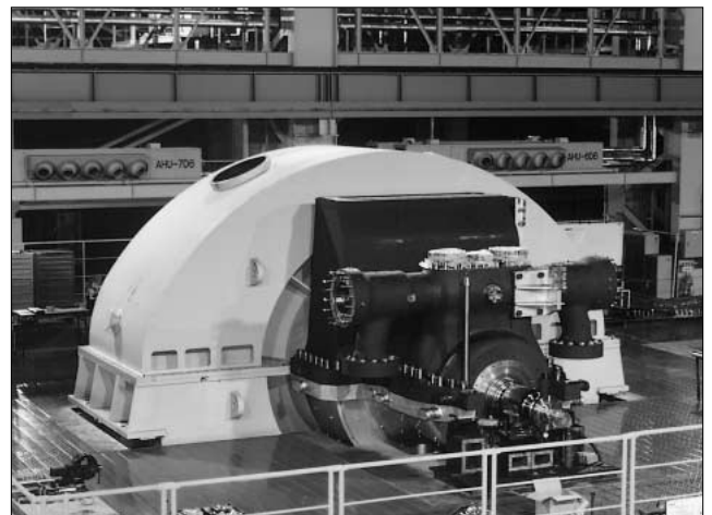
図6 工場での最終組立中の新港工場向け蒸気タービン
