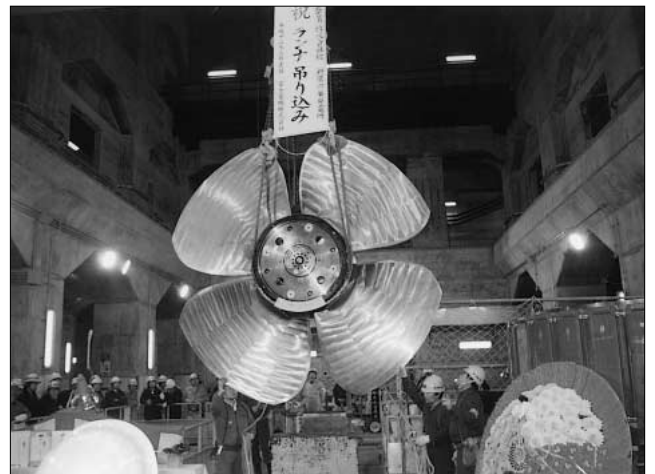
図 11 ランナのつり込み状況
