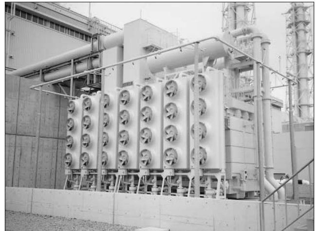
図17 富津火力発電所における主変圧器の据付け状況
