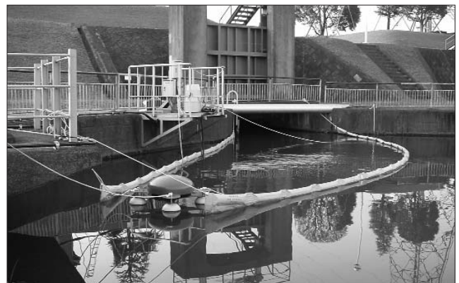
図6 設置場所の全景
