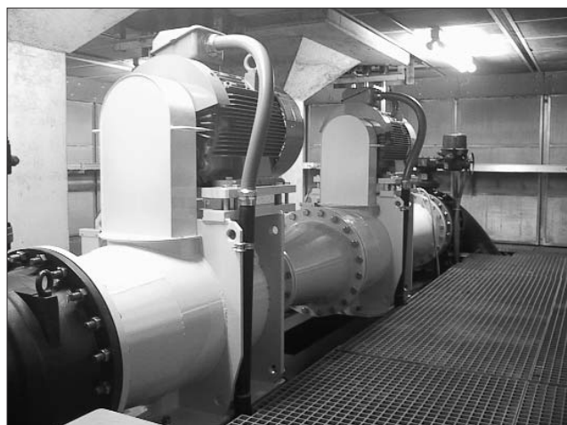
図 22 戦略機種マイクロチューブラ水車
