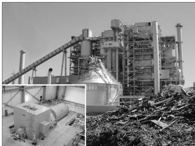
図8 プラント全景とSTG設備（右手前は燃料の廃木材）
