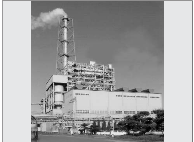
図4 発電所の全景
