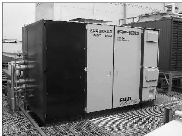
図 19 100 kW リン酸形燃料電池
